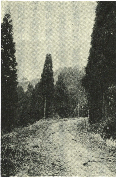
開削された天田峠新道
